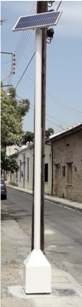
Ιστός στήριξης με φωτοβολταϊκό πλαίσιο
